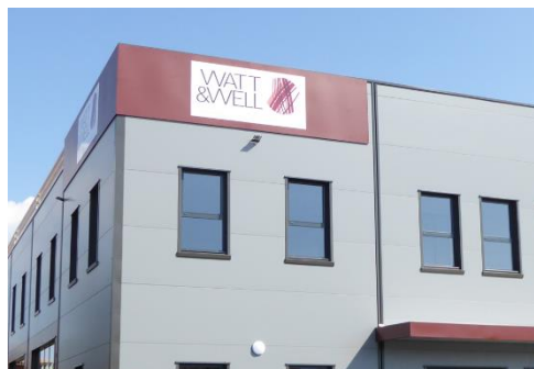
Etablissement de production construit par Watt & Well basé à Pertuis (84120).
